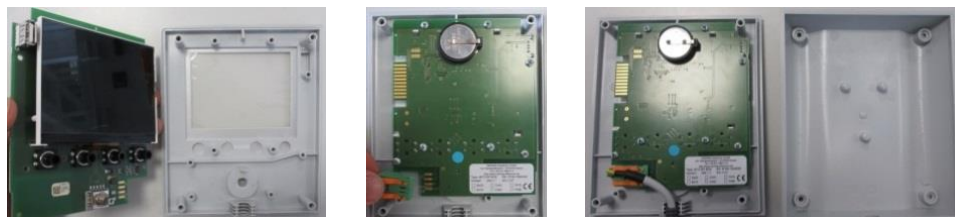
Slika 15: Vgradnja vezja krmilnika – 2. del (podobno kot na sliki)
